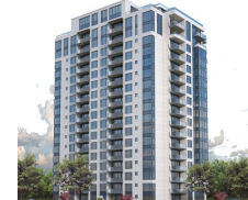
La tour d'habitation
